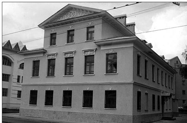
Рис. 2. Фасад Дома художников в Ярославле утеплен с помощью системы «Шуба плюс»
