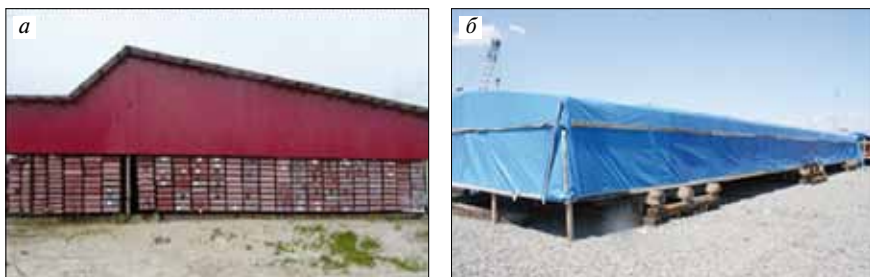
Рис. 3. Хранение элементов КДК под стационарным навесом (а) и временным укрытием (б)
