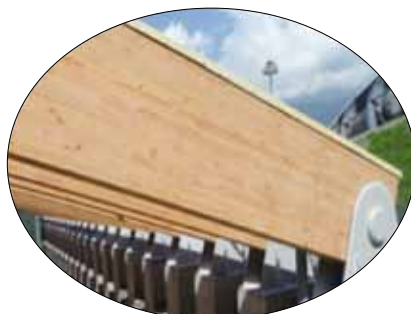
Рис. 9. Лакокрасочное покрытие на несущих КДК (г. Сочи, санно-бобслейная трасса)
