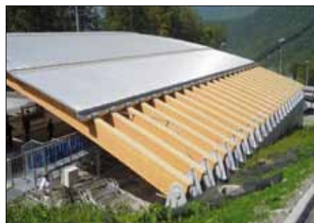
Рис. 9. Лакокрасочное покрытие на несущих КДК (г. Сочи, санно-бобслейная трасса)
