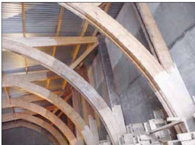
Рис. 4. Потеря внешнего вида КДК в результате неправильного хранения на стройплощадке
