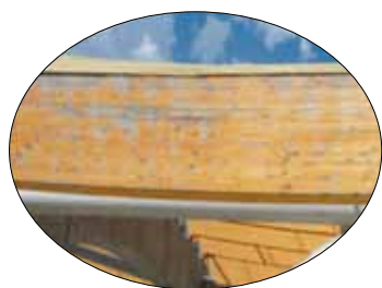
Рис. 8. Состояние лакокрасочного покрытия после года эксплуатации на открытом воздухе в результате нарушения технологии защитной обработки (г. Сочи, санно-бобслейная трасса)
