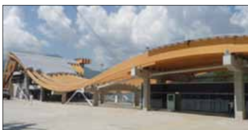
Рис. 8. Состояние лакокрасочного покрытия после года эксплуатации на открытом воздухе в результате нарушения технологии защитной обработки (г. Сочи, санно-бобслейная трасса)
