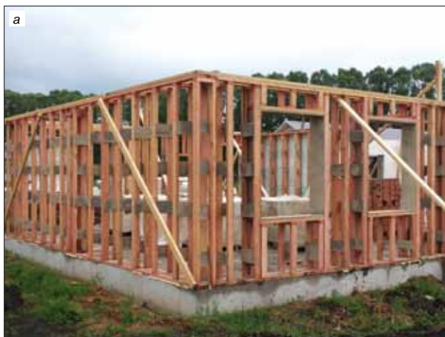
Рис. 1. Процесс сборки деревянного каркаса и обшивка листами фибролита
