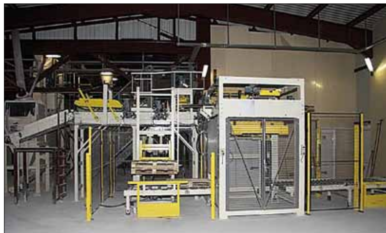
Рис. 14. Установка укладки мешков на поддоны
