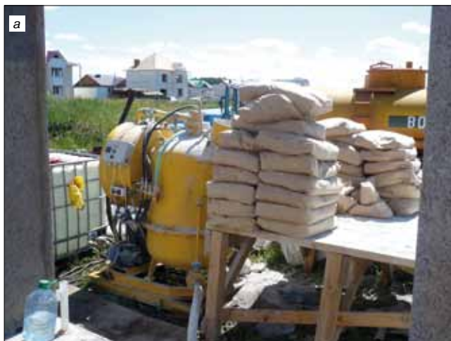
Рис. 2. Процесс заливки пеногипса в конструкции наружной стены
