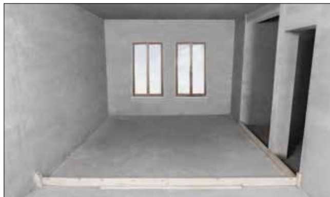
Выравнивающая стяжка на изолирующем слое из пенополистирольных плит
