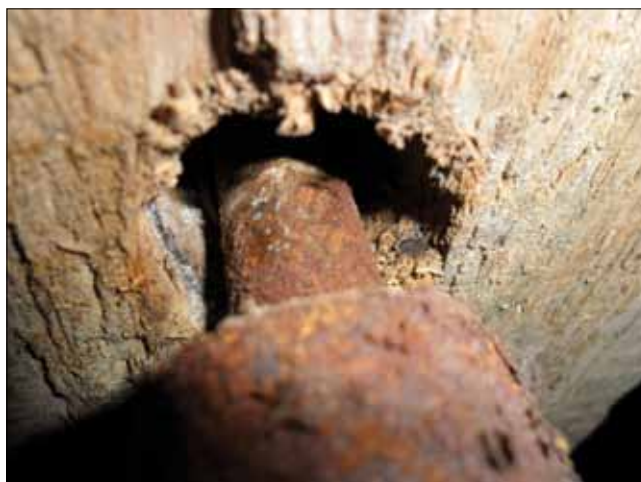
Рис. 1. Нагельное соединение составной балки стропильной конструкции. Учебный корпус № 2 Поволжского государственного технологического университета
