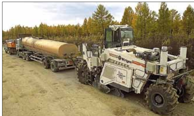
Строительство первого этапа автодороги Чита – Хабаровск
