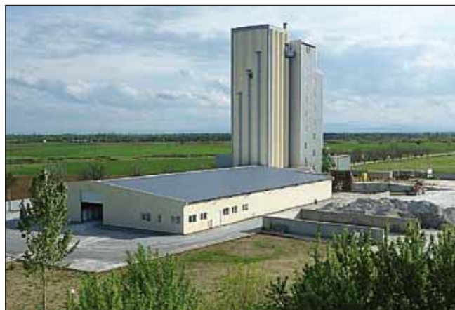
Рис. 1. Новый завод Green Field (на новом месте)
