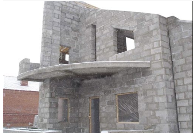
Рис. 4. Возведение коттеджа в Иркутской обл. со стеновыми блоками и перемычками из модифицированного полистиролбетона (2003 г.)
