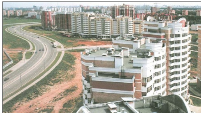
Рис. 8. Панорама жилых зданий мкр. Куркино (Москва, 2005–2006 гг.) с наружными стенами, возведенными с использованием монолитной теплоизоляции из модифицированного полистиролбетона марки по плотности D200–D250 в несъемной опалубке
