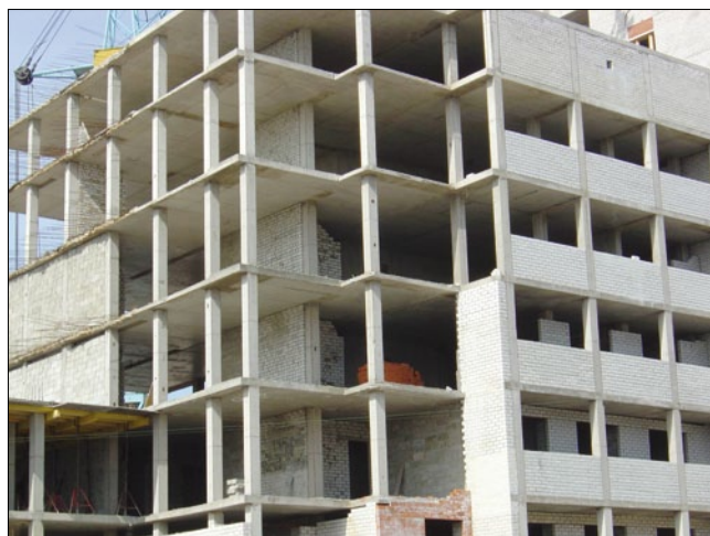
Рис. 2. Возведение монолитного несущего каркаса из легких бетонов классов В15–В40 на пористом шлакостеклогрануляте НЛМК и наружных стен с монолитной теплоизоляцией из полистиролбетона марки по плотности D250 в несъемной опалубке при возведении жилого здания в Воронеже, 2004 г.
