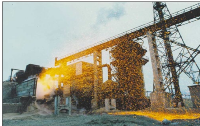
Рис. 1. Установка по производству остеклованного пористого заполнителя из доменных шлаков текущего выхода (шлакостеклогранулята) на Новолипецком металлургическом комбинате. Ввод в действие первой очереди – 1999 г. (Патент РФ на изобретение № 2087438. Установка для производства шлакопемзowego гравия // В.Ф. Панченко, И.В. Франценюк, Г.А. Денисов, Я.Ш. Школьник, В.Н. Ярмаковский, В.Н. Каданцев, А.С. Коротаев. Б.И. № 23. Оpubл. 20.08.1997 г.)
