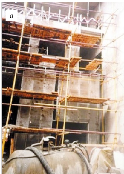
Рис. 10. Строительство комплекса зданий делового центра «Царев сад» (Москва, Софийская наб., д. 36): а – фрагмент бетонирования практически однослойной стены ( \delta_{\text{общ}}=35 см при R_0=3,15 м. 2 С/Вт), возводимой в несъемной опалубке из объемной ( \delta=40 мм) оцинкованной просечной сетки. Использован особо легкий (марки по плотности D250) монолитный полистиролбетон. Высокопоризованные полистиролбетонные смеси подаются и укладываются в опалубку без виброуплотнения с помощью бетононасосов мобильной установки. Технология разработана НИИЖБ с участием НИИСФ (1999–2000 гг.); б – внешний вид стен зданий после отделки
