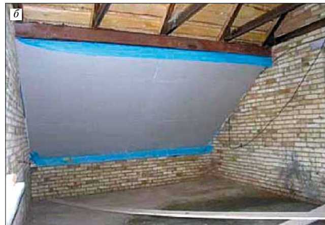
Рис. 5. Этапы возведения мансарды (а – начальный, б – завершающий) коттеджа в г. Белебее. Несъемная опалубка выполнена из гипсокартона, внутреннее заполнение крупнопористым керамзитобетоном
