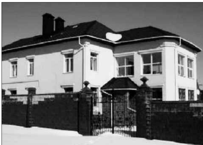
Рис. 3. Коттедж в п. Михайловка Уфимского района с наружными стенами, выполненными в колодезной кладке, и внутренним слоем из крупнопористого керамзитобетона
