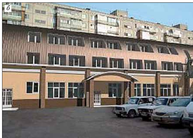
Рис. 2. Реконструкция одноэтажного здания Уфимского филиала РГСУ с надстройкой двух дополнительных этажей. В качестве стенового ограждения использован прокатный профнастил (наружный слой) с заполнением внутреннего слоя крупнопористым керамзитобетоном: а – вид здания до реконструкции; б – вид здания после реконструкции
