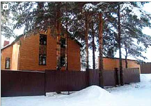
Рис. 4. Главный (а) и дворовый (б) фасады коттеджа в г. Белебее с мансардой, а также с наружными стенами, выполненными в колодезной кладке с применением крупнопористого керамзитобетона
