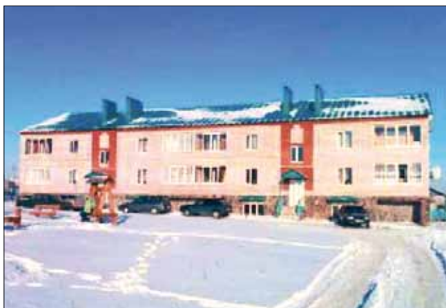
Рис. 1. Главный фасад двухэтажного жилого дома с цокольным этажом, наружные стены из керамзитобетонных блоков с кирпичной облицовкой (п. Кармаскалы, ул. Ленина, 39 Б)
