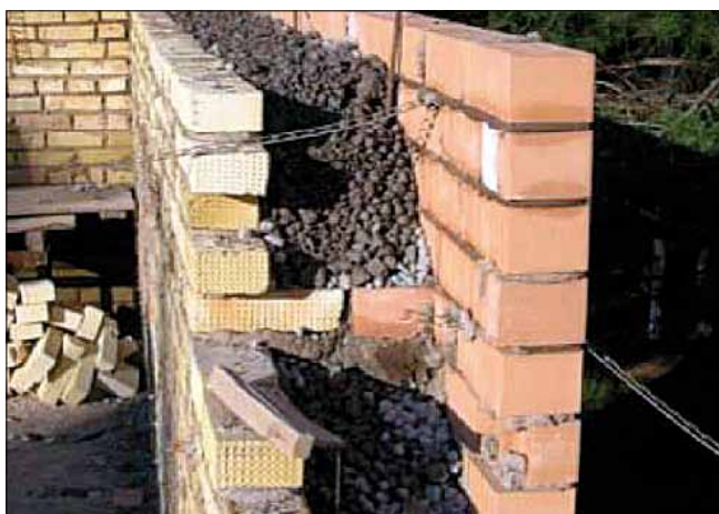
Рис. 7. Облегченная кирпичная кладка, разработанная Н.С. Поповым в 1939 г., и ее практическое исполнение с использованием крупнопористого керамзитобетона
