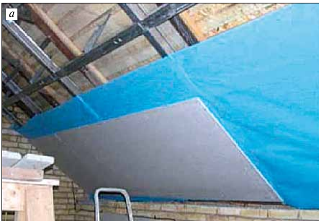
Рис. 5. Этапы возведения мансарды (а – начальный, б – завершающий) коттеджа в г. Белебее. Несъемная опалубка выполнена из гипсокартона, внутреннее заполнение крупнопористым керамзитобетоном
