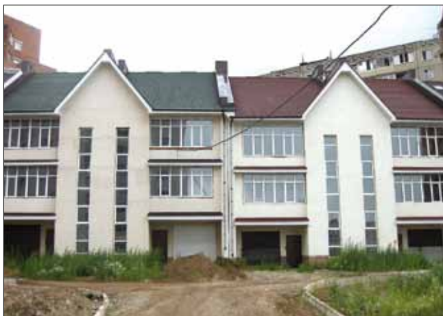
Рис. 8. Общий вид и выделенный фрагмент сблокированных индивидуальных жилых домов (типа таун-хаусов) в Кировском р-не г. Уфы с наружными стенами, выполненными в колодцевой кладке с использованием крупнопористого керамзитобетона.
