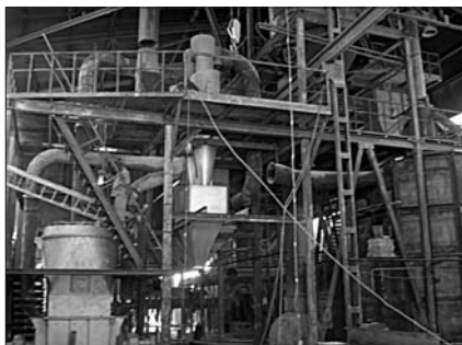
Строительство второй очереди производства
