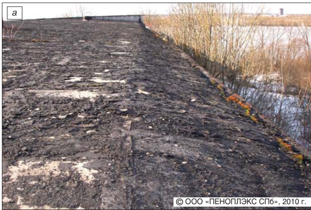
Рис. 2. Промышленное здание в г. Кириши (Ленинградская обл.): а – до ремонта кровли; б – после ремонта кровли с материалом ПЛАСТФОИЛ®
