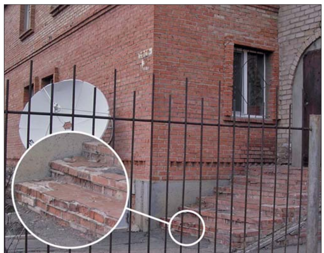
Рис. 4. Кладка ступеней из пустотного кирпича
