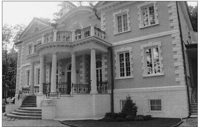
Для отделки фасада усадьбы «Подмосковная Англия» из полимергипса «Столица» изготовлены колонны и накладные элементы углов и окон
