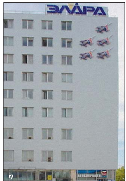
Рис. 5. Навесная система SPIDI ® использована при устройстве фасадов в различных регионах РФ: а) керамогранит, Казань; б) волокнисто-цементные плиты, Новосибирск; в) композитные кассеты, Москва; г) профилированный алюминий, Чебоксары
