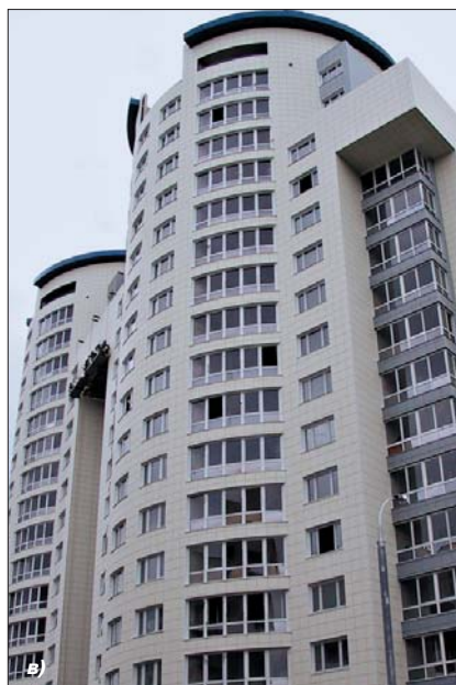
Рис. 5. Навесная система SPIDI ® использована при устройстве фасадов в различных регионах РФ: а) керамогранит, Казань; б) волокнисто-цементные плиты, Новосибирск; в) композитные кассеты, Москва; г) профилированный алюминий, Чебоксары
