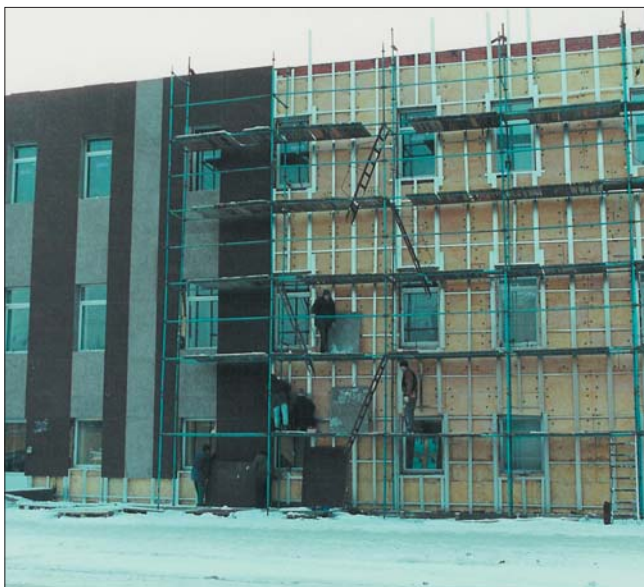
Реконструкция фасада офисного здания в Санкт-Петербурге с использованием материалов URSA®
