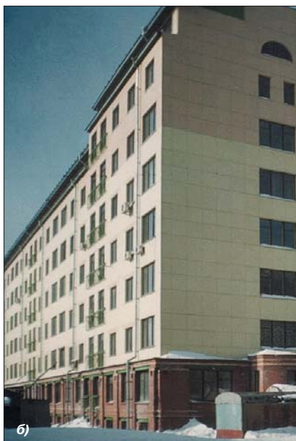
Рис. 5. Навесная система SPIDI ® использована при устройстве фасадов в различных регионах РФ: а) керамогранит, Казань; б) волокнисто-цементные плиты, Новосибирск; в) композитные кассеты, Москва; г) профилированный алюминий, Чебоксары
