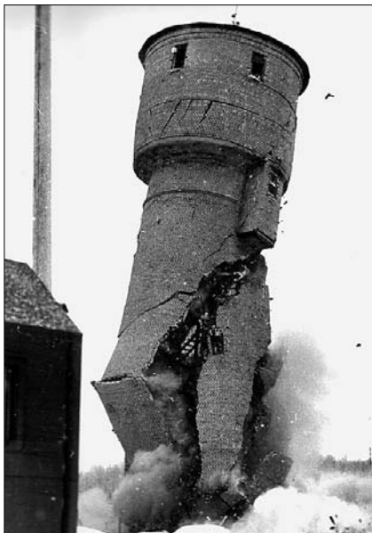
Обрушение водонапорной башни
