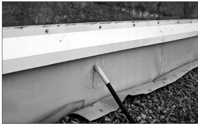
Рис. 4. Мембрана «Sikaplan VGWT» защищена от повреждений геотекстилем и слоем гравия
