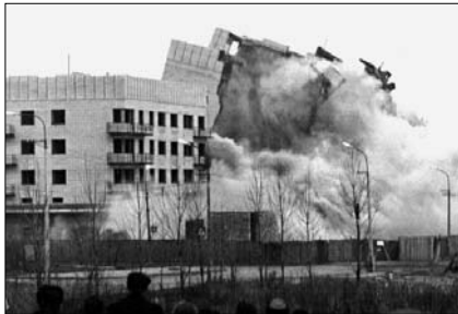
Направленное обрушение части жилого кирпичного здания
