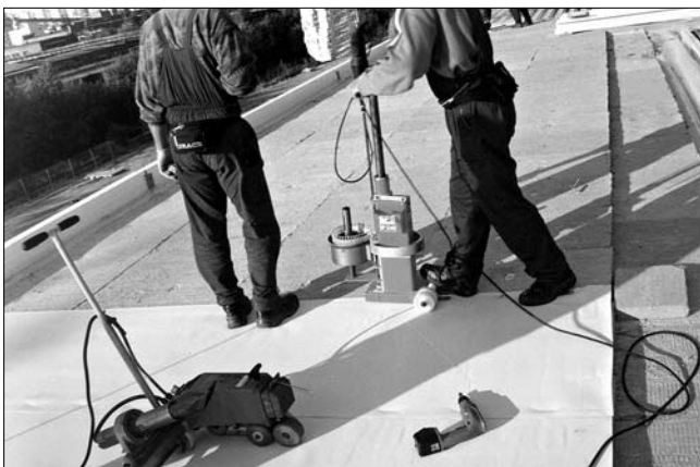
Рис. 5. Механическое крепление мембран производится дюбель-гвоздями
