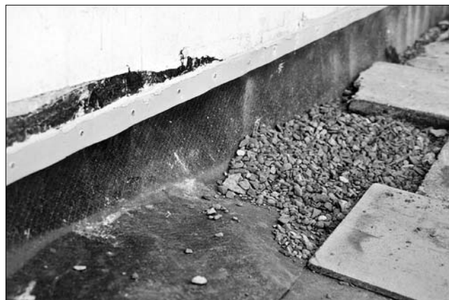
Рис. 2. Зона примыкания кровли к стене, имеющей козырек
