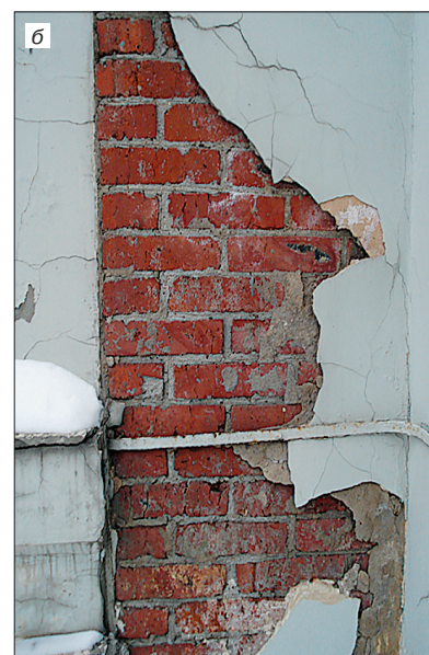
Рис. 3. Разрушение кладки из полнотелого керамического кирпича под слоем: а – цементно-песчаной штукатурки. Локомотивный пр., д. 7 Москва, Россия; б – известковой штукатурки. Малая Калужская ул., д. 27, Москва, Россия
