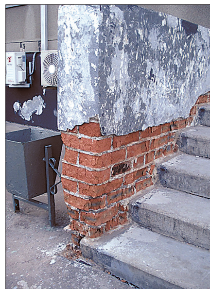
Рис. 5. Разрушение ограждающей стены из полнотелого керамического кирпича, оштукатуренной цементно-песчаным раствором, Москва, Россия
