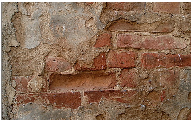
Рис. 2. Разрушение единственного кирпича из кладки полнотелого керамического кирпича в г. Сиена, Италия
