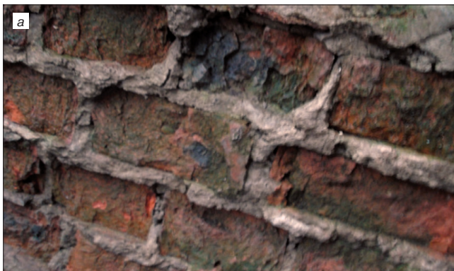
Рис. 4. Разрушение кирпичной кладки из полнотелого керамического кирпича: а – разрушение кирпича, Москва, Россия; б – разрушение вяжущего раствора, Сиена, Италия
