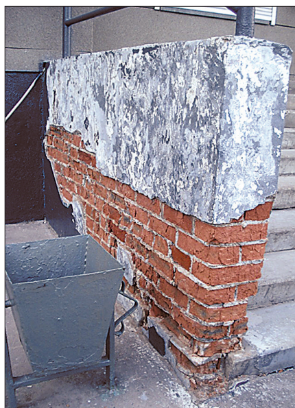
Рис. 5. Разрушение ограждающей стены из полнотелого керамического кирпича, оштукатуренной цементно-песчаным раствором, Москва, Россия
