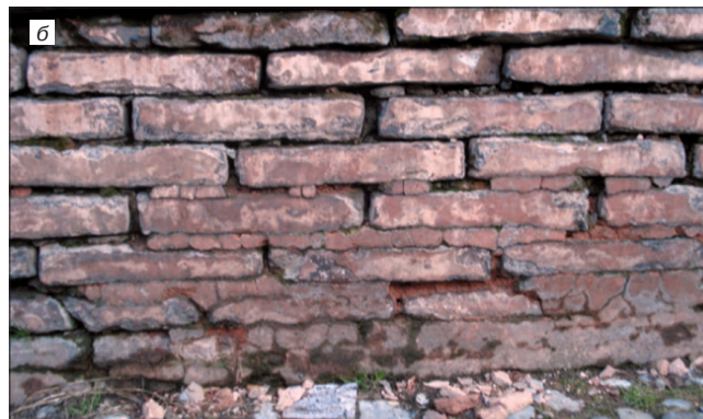
Рис. 4. Разрушение кирпичной кладки из полнотелого керамического кирпича: а – разрушение кирпича, Москва, Россия; б – разрушение вяжущего раствора, Сиена, Италия
