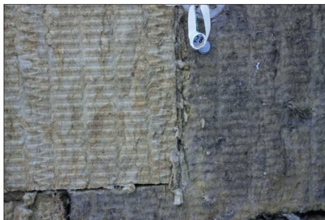
Рис. 2. Поверхность минераловатного утеплителя из каменной ваты, обращенная в воздушную прослойку вентфасада
