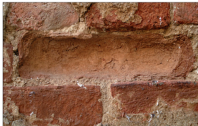
Рис. 2. Разрушение единственного кирпича из кладки полнотелого керамического кирпича в г. Сиена, Италия
