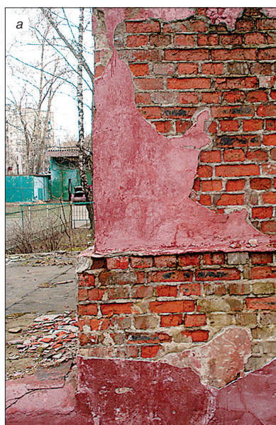
Рис. 3. Разрушение кладки из полнотелого керамического кирпича под слоем: а – цементно-песчаной штукатурки. Локомотивный пр., д. 7 Москва, Россия; б – известковой штукатурки. Малая Калужская ул., д. 27, Москва, Россия
