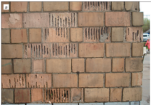
Рис. 1. Разрушение кладки из керамического кирпича. а – облицовочный слой из щелевого керамического кирпича здания второй половины XX в., Москва, Россия; б - кладка из полнотелого керамического кирпича (верхняя часть) крепостной стены XII-XV вв., г. Сиена, Италия.
