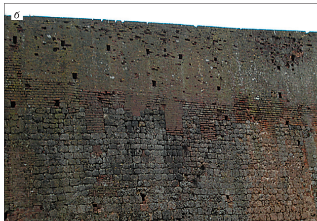
Рис. 1. Разрушение кладки из керамического кирпича. а – облицовочный слой из щелевого керамического кирпича здания второй половины XX в., Москва, Россия; б - кладка из полнотелого керамического кирпича (верхняя часть) крепостной стены XII-XV вв., г. Сиена, Италия.
