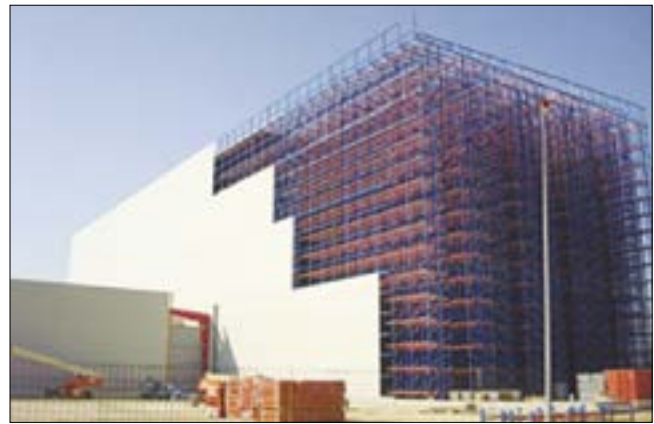
Рис. 3. Возведение промышленного здания с использованием сэндвич-панелей
