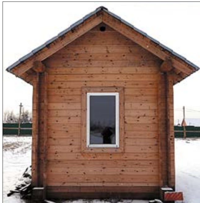
Рис. 1. Общий вид экспериментального дома из двойного бруса
