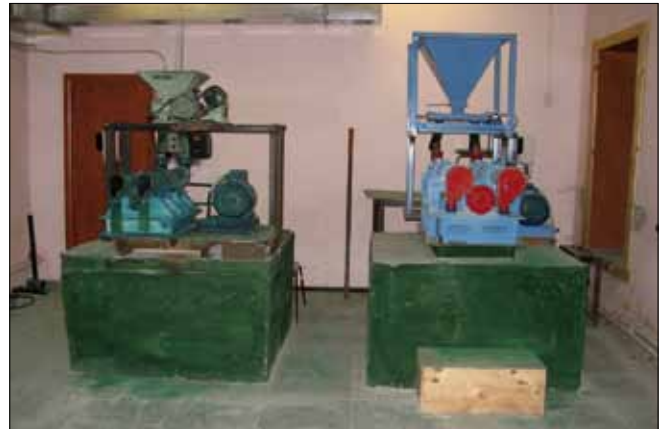
Рис. 5. Монтаж двух установок производительностью 50 и 100 кг/ч для производства композиционных пигментов
