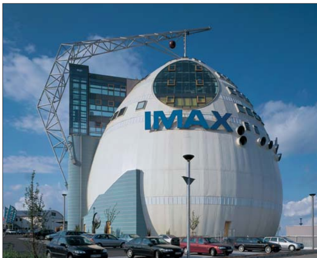
Рис. 1. Кровли сложной формы выполнены из полимерных мембран
