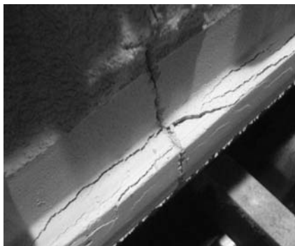
Рис. 4. Отколы и трещины
