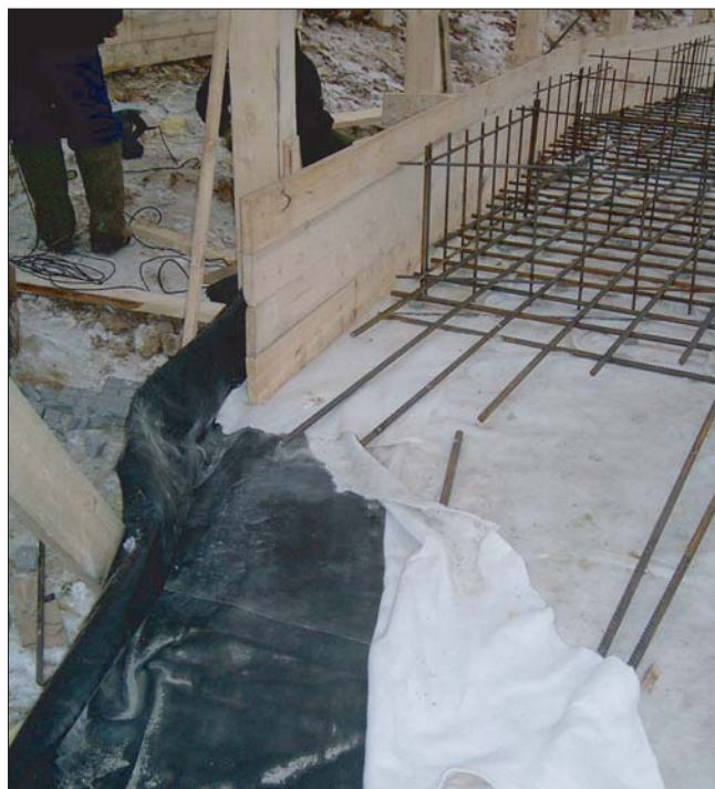
Рис. 1. Фрагмент бетонного фундамента со слоем ЭПИКРОМа перед заливкой
