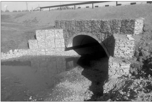
Рис. 3. Возведенные малопролетные засыпные сталефибробетонные мосты в Республике Башкортостан: а – трехшарнирный арочный мост пролетом 6 м (г. Янаул, лето 2007 г.); б – двухпролетный арочный мост пролетом 2×4 м (г. Бирск, лето 2007 г.)
