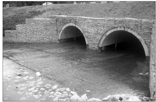
Рис. 3. Возведенные малопролетные засыпные сталефибробетонные мосты в Республике Башкортостан: а – трехшарнирный арочный мост пролетом 6 м (г. Янаул, лето 2007 г.); б – двухпролетный арочный мост пролетом 2×4 м (г. Бирск, лето 2007 г.)
