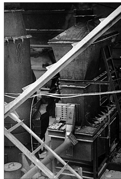
Рис. 1. Печь кипящего слоя для предварительной термopодготовки перлитового сырья
