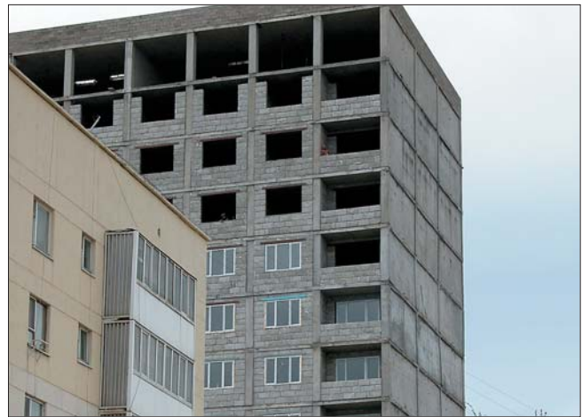
Строительство жилья и общественных зданий ведется монолитно-каркасным методом
