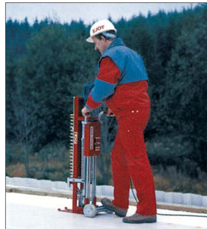
Рис. 4. Высокая производительность работ с установкой EJOТ ECOset HTK обеспечивается эргономичностью оборудования
