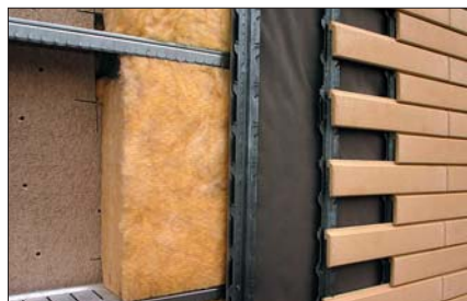
Рис. 3. Теплоизоляционные плиты ISOVER KL 37 в конструкции навесной вентилируемой фасадной системы «Марморок»
