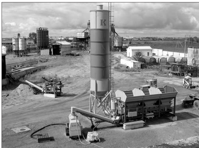
Механизированный бетоносмесительный узел
