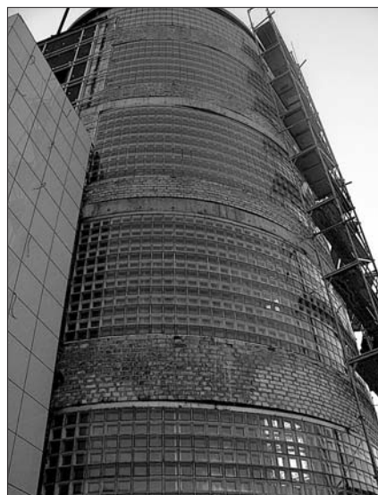
Рис. 4. Кладка из стеклоблоков на модифицированном перлитобетонном растворе
