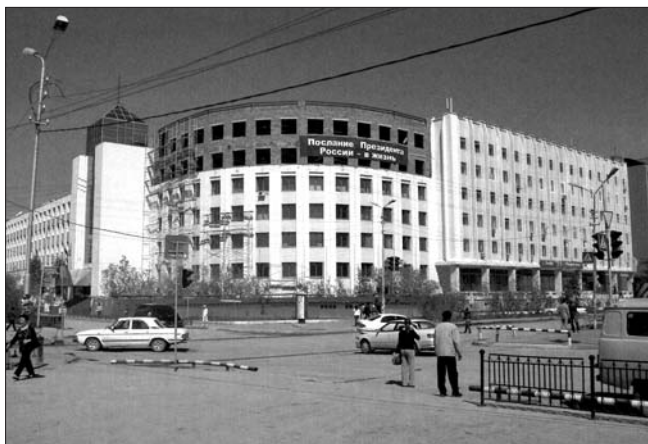
Надстройка административного здания в г. Якутске из легких керамзитобетонных блоков.
