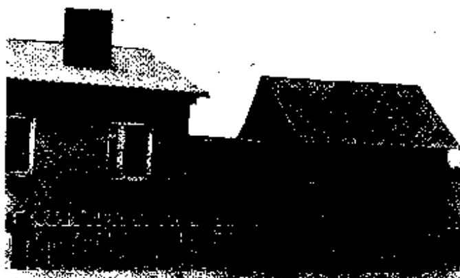
Рис. 3. Хозяйственные надворные постройки из асбестоцементных панелей — отдельно стоящие (а) и облокотанные с жилым (б)
