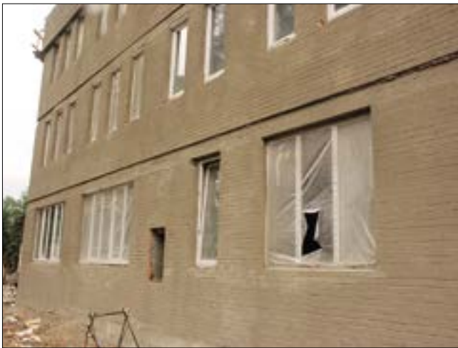
Рис. 1. Исключение «мостиков холода» с помощью галтелей из фибропенобетона
