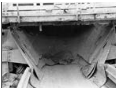
Рис. 1. Установка резиновых уплотнителей в приемном бункере ленточного конвейера
