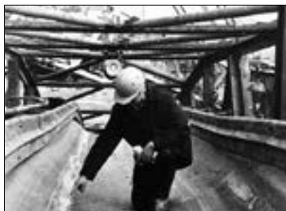
Рис. 2. Фрагмент продольного полосового износа верхней рабочей обкладки резиноканвеейной ленты конвейера
