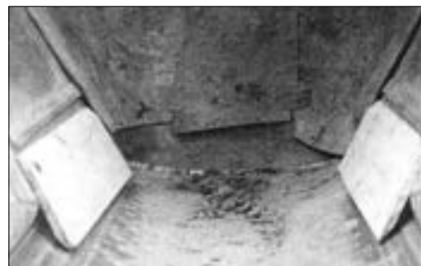
Рис. 3. Установка полимерных уплотнителей на основе ППФП-Астики в приемном бункере ленточного конвейера
