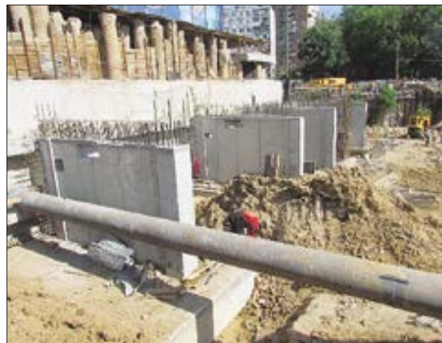
Рис. 2. Фрагменты выполненных контрфорсов
