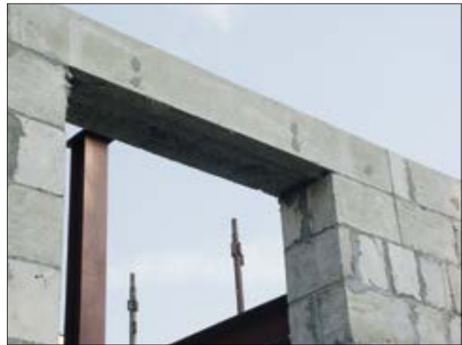
Рис. 2. Фибропеножелезобетонная перемычка на объекте цех фасовки медикаментов
