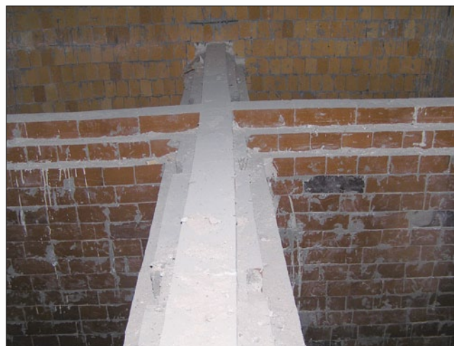
Рис. 3. Керн выполнен из огнеупорного кирпича на кладочном растворе СВС-мергель
