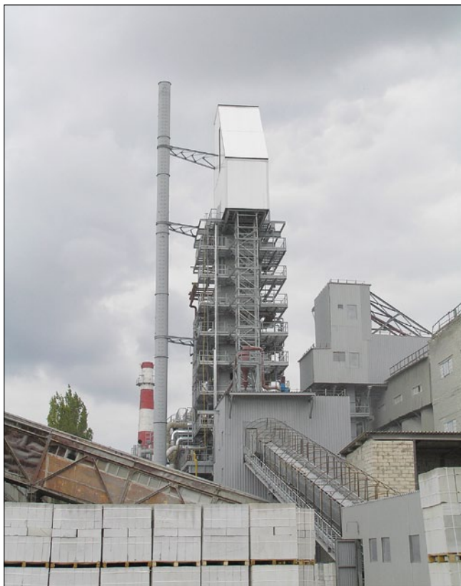
Рис. 1. Общий вид печи на Старооскольском комбинате строительных материалов
