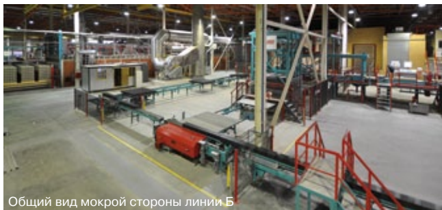
Общий вид мокрой стороны линии Б
