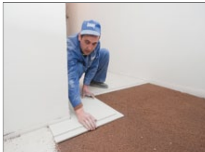
Укладка угловых элементов
