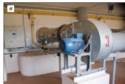
Рис. 4. Сушильная камера со стороны системы теплоснабжения: а – общий вид системы теплоснабжения, расположенной в техническом помещении сзади сушильных камер; б – вид со стороны дроссельной заслонки Y1 подачи воздуха из цеха; в – вид со стороны шкафа управления процессом сушки
