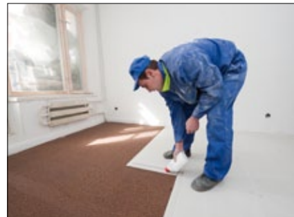
Нанесение клея на стыкуемую поверхность
