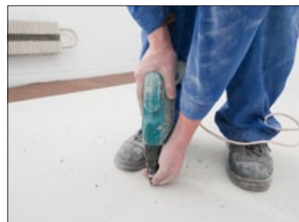
Крепление элементов пола винтами
