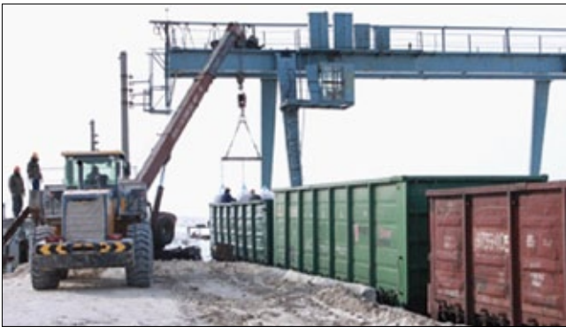
Промплощадка с ж/д тупиком и всей необходимой техникой
