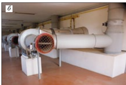
Рис. 4. Сушильная камера со стороны системы теплоснабжения: а – общий вид системы теплоснабжения, расположенной в техническом помещении сзади сушильных камер; б – вид со стороны дроссельной заслонки Y1 подачи воздуха из цеха; в – вид со стороны шкафа управления процессом сушки
