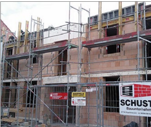
Рис. 1. Строительство жилого дома в Мюнхене из крупноформатных камней с заполненными минеральной ватой пустотами (2012 г.)
