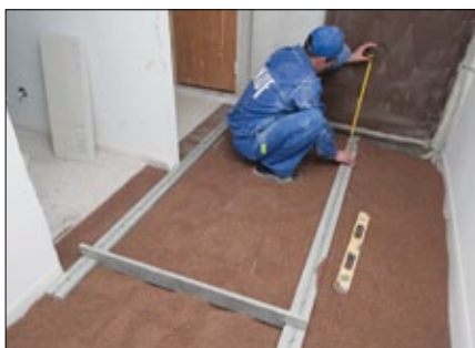
Выравнивание керамзитового слоя
