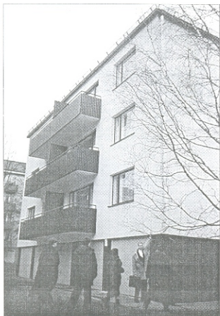
Рис. 2. Жилой дом в Хельсинки, для дополнительной теплоизоляции которого использованы плиты ППС «NESTE Chemicals»
