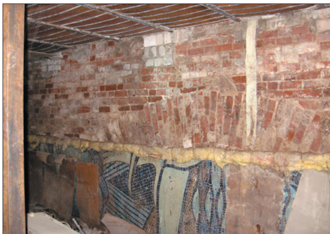
Рис. 1. Дефекты и повреждения кирпичной кладки подвального помещения нежилого здания
