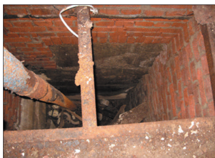
Рис. 2. Дефекты и повреждения кирпичной кладки технологического углубления бывшей насосной станции
