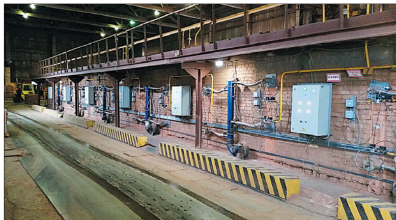
Рис. 1. Система отопления кольцевой печи
