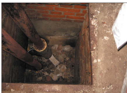
Рис. 2. Дефекты и повреждения кирпичной кладки технологического углубления бывшей насосной станции
