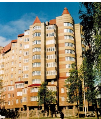
Рис. 3. Жилой 12-этажный дом в Уфе (ул. Дорофеева) с теплоэффективными наружными трехслойными стенами на основе высокопустотных вибропрессованных бетонных блоков (постройка 1998 г.)
