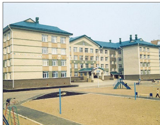
Рис. 5. Школа в Уфе (микрорайон Сипайлово) с теплоэффективными наружными трехслойными стенами на основе высокопустотных вибропрессованных бетонных блоков (постройка 2003 г.)
