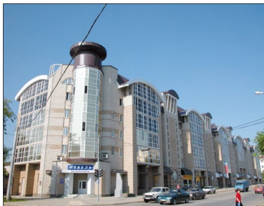
Рис. 4. Жилой семиэтажный дом в Уфе (ул. Чернышевского) с теплоэффективными наружными трехслойными стенами на основе высокопустотных вибропрессованных бетонных блоков (постройка 2001 г.)
