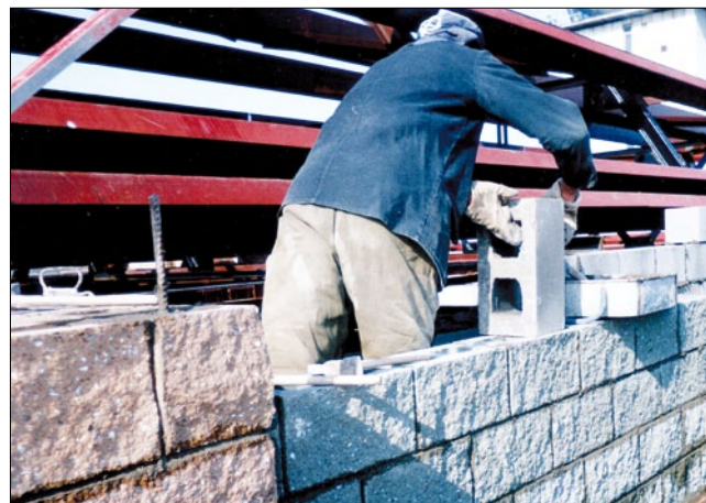
Рис. 7. Процесс кладки из высокопустотных вибропрессованных бетонных блоков на примере возведения здания международного терминала аэропорта Уфы
