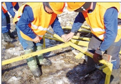
Рис. 5. Сборка монтажной рамы
