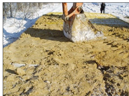
Рис. 10. Трамбовка грунта ковшом экскаватора
