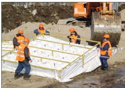
Рис. 6. Натягивание Геоматрицы ГМ на монтажную раму
