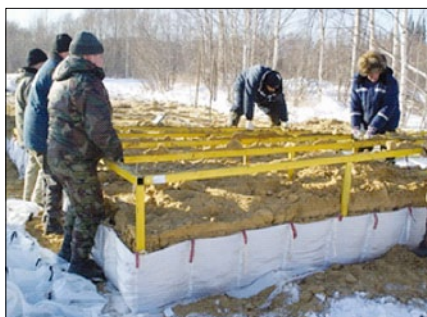
Рис. 8. Демонтаж рамы высотой до 0,5 м
