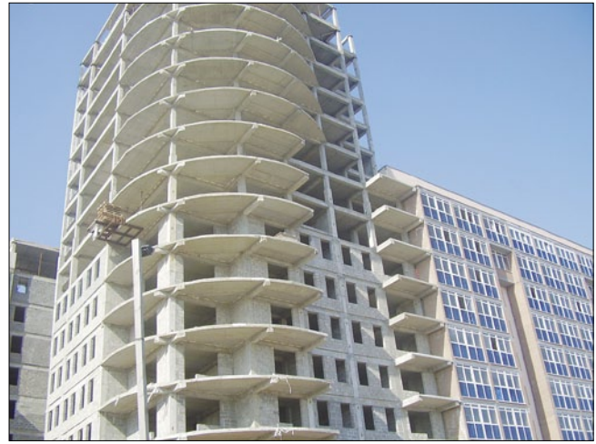
Рис. 7. Возведение 16-этажного каркасно-панельного жилого здания в Нижнем Новгороде с несущим каркасом типа Saret из керамзитобетонных элементов производства Новочебоксарского ДСК, а также с трехслойными наружными стеновыми панелями с наружным и внутренним слоями из керамзитобетона и гибкими связями из базальтопластика (2005 г.)
