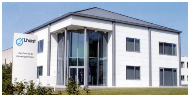
Рис. 2. Здание офиса со стенами из газобетонных панелей
