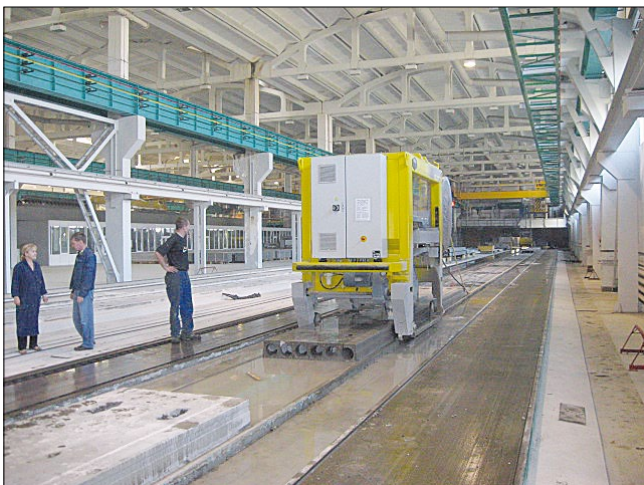
Рис. 8. Технологическая линия формования на длинных стандах завода КПД Новочебоксарского ДСК предварительно напряженных многослойных панелей перекрытий из керамзитобетона класса по прочности В30 для несущего сборно-монолитного каркаса жилых каркасно-панельных зданий или для стеновых систем крупнопанельных зданий (2004 г.)
