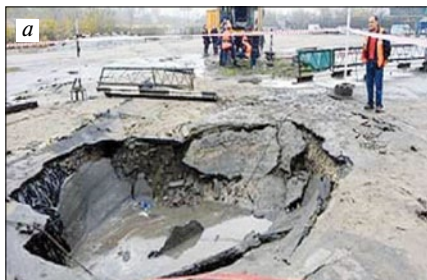
Рис. 1. Деформации в покрытии автодороги (а); деформации в земляном полотне автодороги (б)
