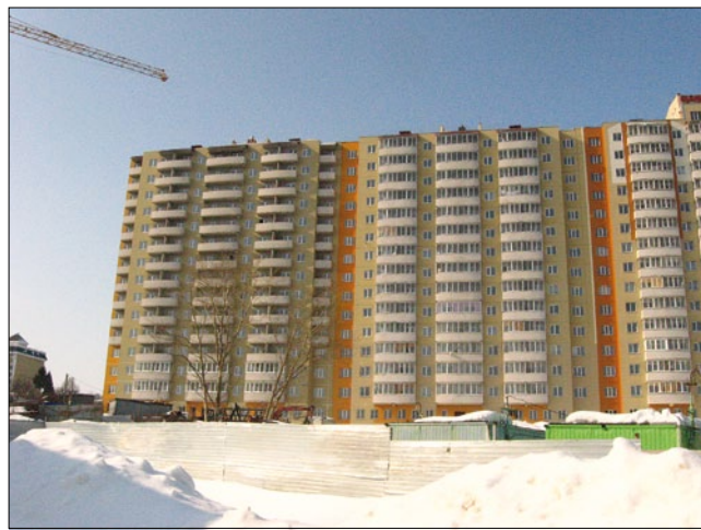
Рис. 9. Комплекс крупнопанельных зданий с трехслойными наружными стеновыми панелями из керамзитобетона и гибкими базальтопластиковыми связями, внутренними стенами и панелями перекрытий из керамзитобетона (микрорайон Юго-Западный, г. Чебоксары, 2011 г.)
