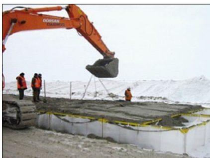
Рис. 9. Демонтаж рамы высотой более 0,5 м
