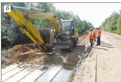
Рис. 15. Укрепление (а) и уширение (б) земляного полотна при капитальном ремонте участка автодороги Занулье–Матвеевская–Гарь–Коржинский
