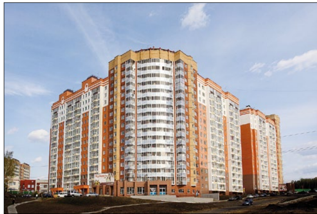
Рис. 4. Комплекс крупнопанельных 16-этажных зданий с использованием керамзитобетона в предварительно напряженных панелях перекрытий и в трехслойных наружных стеновых панелях с жесткими связями-шпонками (Томск, пос. Солнечный, 2011 г.)
