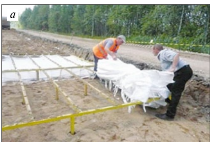
Рис. 15. Укрепление (а) и уширение (б) земляного полотна при капитальном ремонте участка автодороги Занулье–Матвеевская–Гарь–Коржинский
