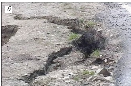
Рис. 1. Деформации в покрытии автодороги (а); деформации в земляном полотне автодороги (б)
