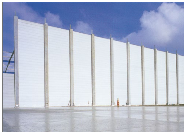
Рис. 3. Стена промышленного здания из стеновых газобетонных панелей
