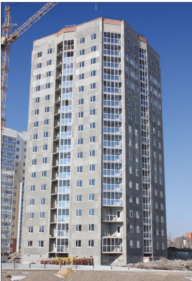
Рис. 5. Каркасно-панельный жилой дом с предварительно напряженными многопустотными панелями перекрытий из керамзитобетона классов В20–В22,5 и трехслойными панелями наружных стен с внутренним и наружным слоями, а также с перемычками (жесткими связями) из керамзитобетона класса В15 (Томск, 2011 г.)
