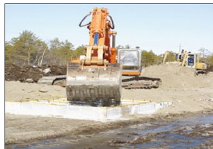
Рис. 7. Засыпка Геоматриц ГМ строительным материалом
