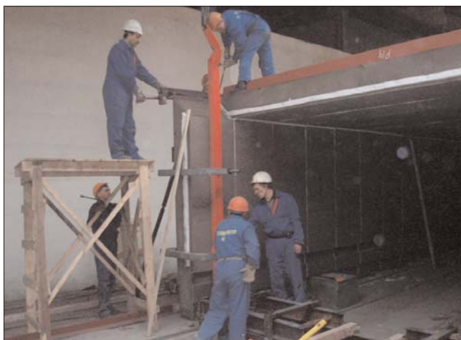
Рис. 1. Монтаж кейзинговой печи по проекту CERIC специалистами ЗАО «Теплохиммонтаж»
