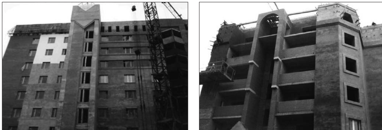
Рис. 2. Оштукатуривание наружных стен цементно-песчаным раствором с добавкой карбонатного шлама
