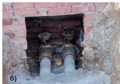
Рис. 4. Локальная тепловая сеть из асбестоцементных труб: а – коллектор; б – ввод в здание
