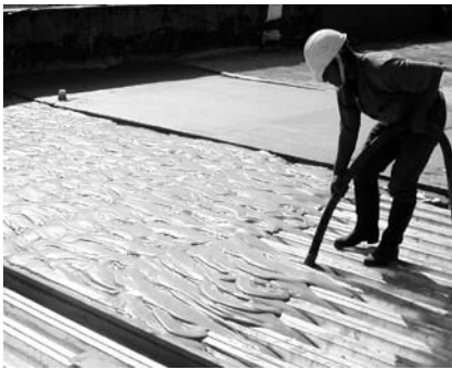
Рис. 2. Процесс нанесения пенобетона
