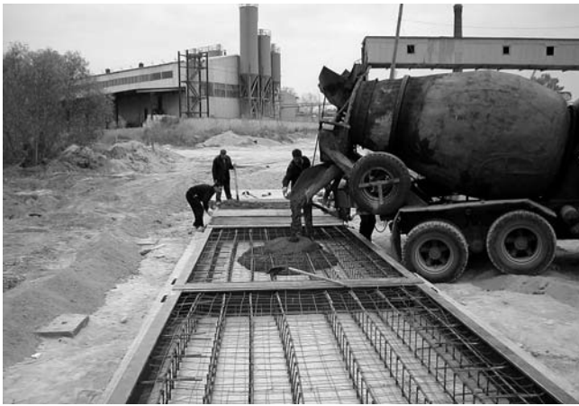
Рис. 3. Процесс заливки грузоприемных платформ
