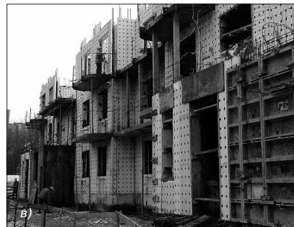
Рис. 3. Возведение жилого дома по системе Пластбау в Москве: а) – монтаж стеновых элементов подземной части здания; б) – монтаж опалубки межэтажного перекрытия; в) – общий вид
