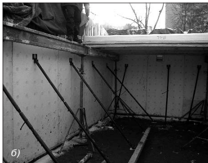
Рис. 3. Возведение жилого дома по системе Пластбау в Москве: а) – монтаж стеновых элементов подземной части здания; б) – монтаж опалубки межэтажного перекрытия; в) – общий вид
