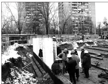
Рис. 3. Возведение жилого дома по системе Пластбау в Москве: а) – монтаж стеновых элементов подземной части здания; б) – монтаж опалубки межэтажного перекрытия; в) – общий вид
