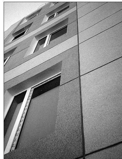
Рис. 2. Внешний вид наружной вермикулитовой штукатурки со специальным декоративным покрытием
