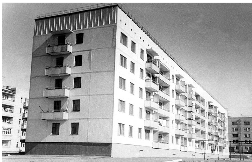
Рис. 1. Отделка фасада, разработанная ЦНИИС совместно с ЦНИИЭПжилища и ЦМИПКС (Чита, серия 135, проект КБ им. А.А. Якушева)
