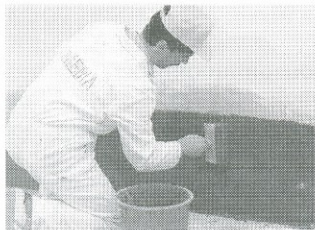
Рис. 1. Нанесение гидроизоляционного материала Hidrotex-94
