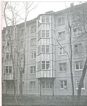
Рис. 3. Общий вид остекленных лоджий с каркасно-подкосной системой в сечении первого этажа
