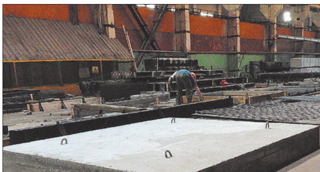
Изготовление объемных ЖБИ на термостенде УТС «Основа»
