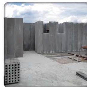
Смонтированные Панели стеновых перегородок
