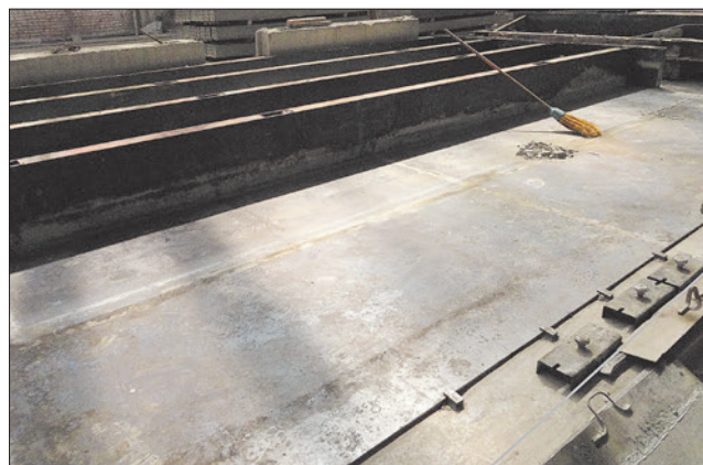
Магнитная и бортовая опалубка на УТС «Основа»
