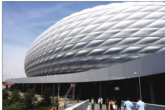
Футуристический овал одного из крупнейших в Европе стадионов «Альянс-Арена» (Allianz Arena) в Мюнхене создан с помощью технологий легкого сухого строительства на базе систем КНАУФ
