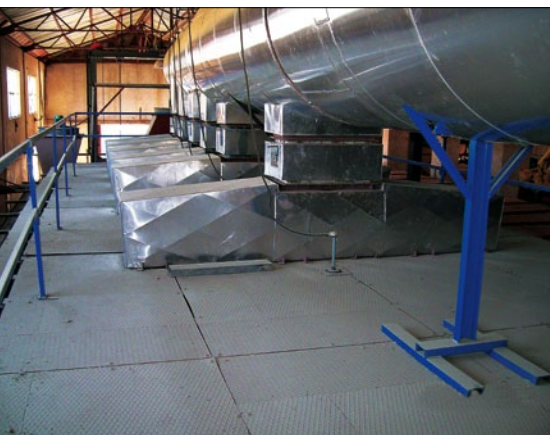
Новая скоростная сушилка на заводе Baraki
