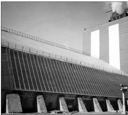
Кровля из Элона хранилища аммиачной селитры ОАО «Дорогобуж» выполнена в 1994 г.
