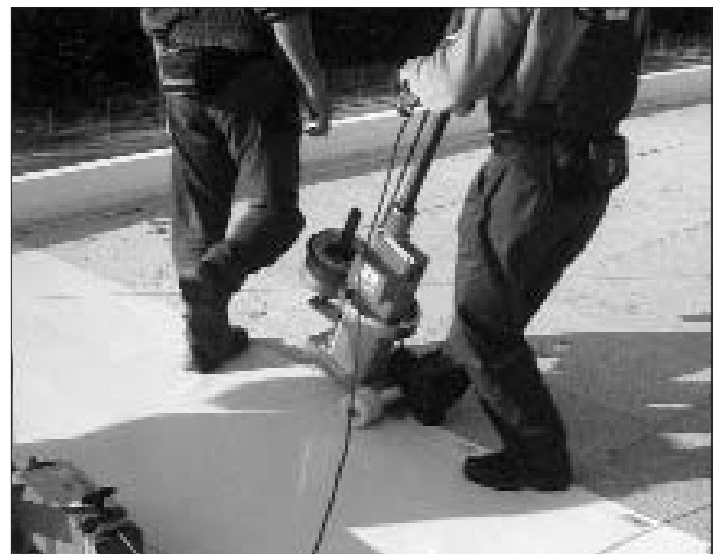
Механический способ крепления кровельных мембран. Материал Sikaplan 15 VGWT. Торговый комплекс «Метро Кэш энд Керри» (Москва)
