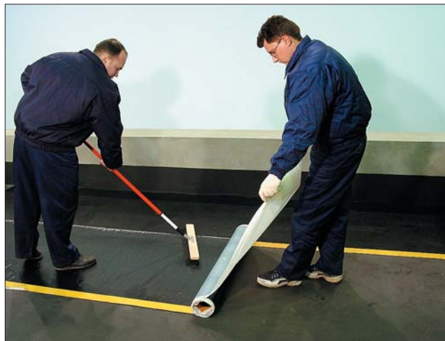
Рис. 1. Укладка самоклеящихся материалов
