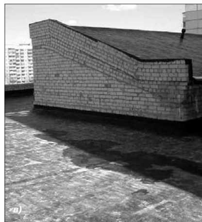
Рис. 2. Устройство теплоизоляционного основания под кровлю: а – укладка теплоизоляционного пенобетона; б – свежеложенный пенобетон; в – готовая крыша с большим уклоном
