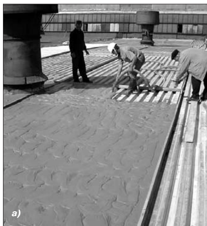
Рис. 2. Устройство теплоизоляционного основания под кровлю: а – укладка теплоизоляционного пенобетона; б – свежеложенный пенобетон; в – готовая крыша с большим уклоном
