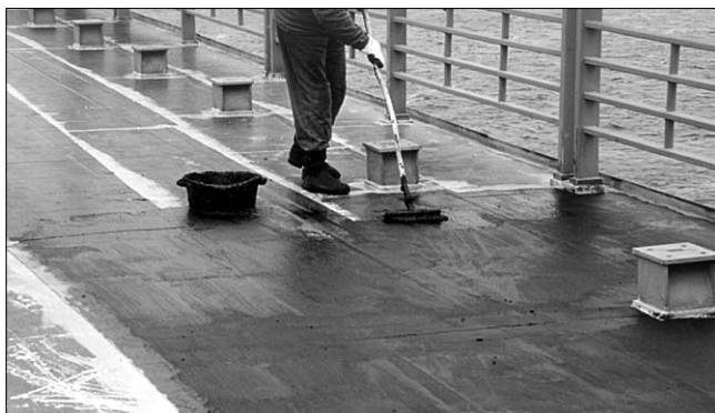
Нанесение праймера «Полибит» повышает адгезию к асфальтобетону
