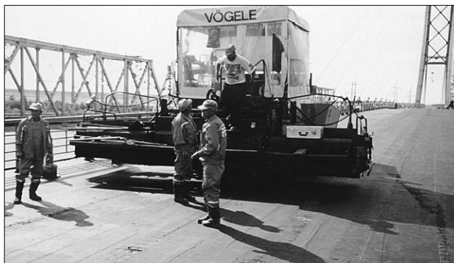
Гидроизоляция легко выдерживает дорожную технику
