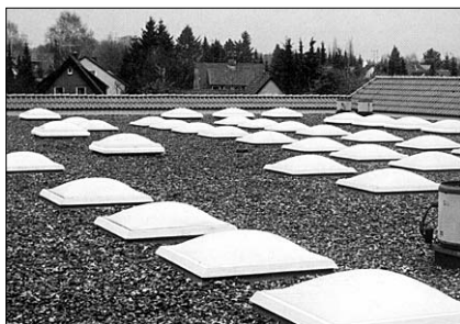
Рис. 1. Кровля здания выполнена из материала Carisma CI с балластным креплением
