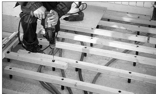
Жесткое крепление регулируемых лаг к основанию производится через болты-стойки
