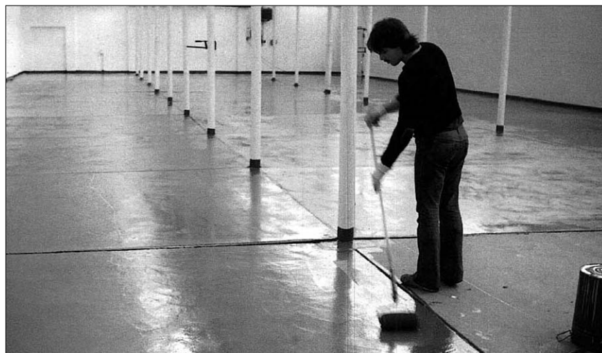
При больших площадях заливка композиции «Эспол» осуществляется картами
