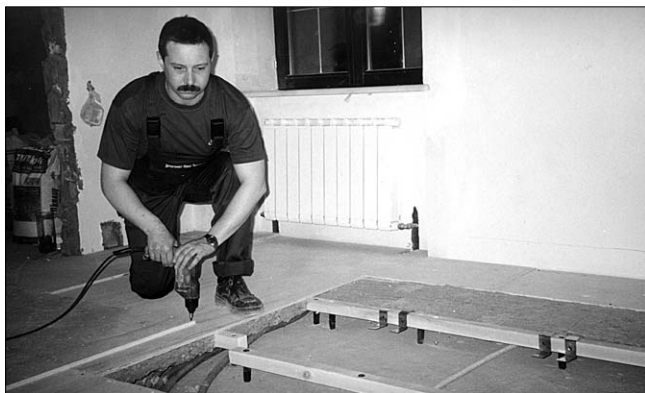
Между лагами укладывается утеплитель, сверху настилается фанера
