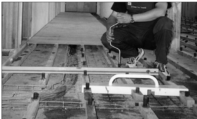
Выравнивание лаг в конструкции пола со встроенными инженерными коммуникациями
