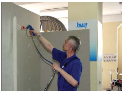
Достаточно открыть ведро, установить его на машину, и можно шпаклевать...
