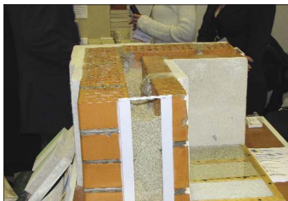
Технологию задувки мелкодисперсного вермикулита внутрь кирпичной кладки предлагали на стенде Украинского вермикулитового дома
