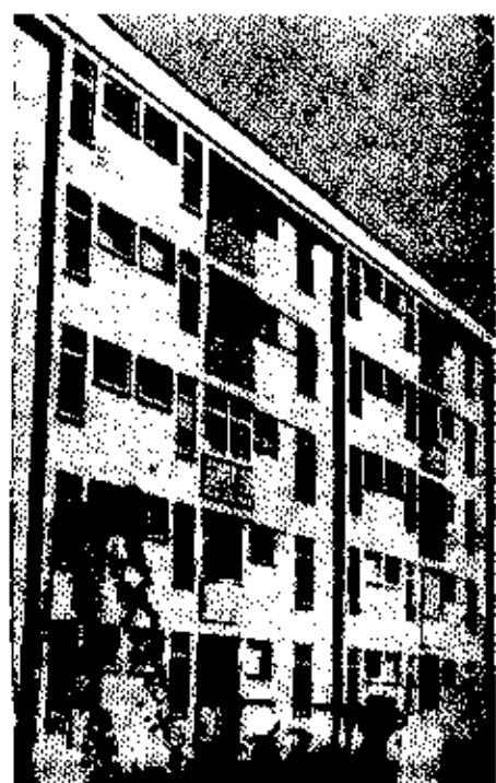
Жилый дом из ячеистого бетона в г. Белгород-Днестровский
