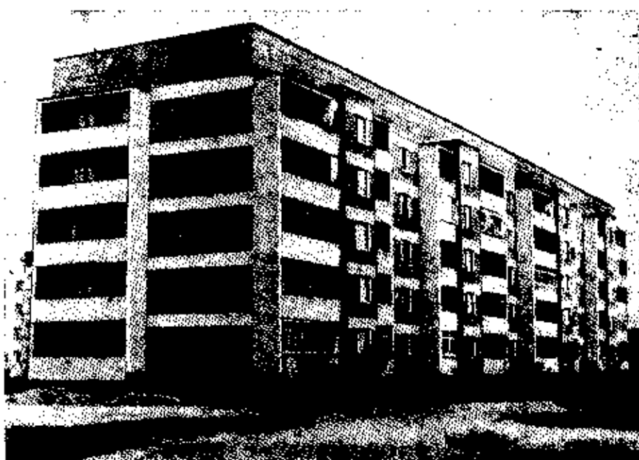
Жилый дом из ячеистого бетона в г. Славути
