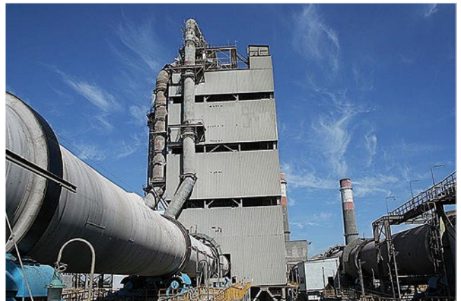
Печь № 8 на ОАО «Себряковцемент»
