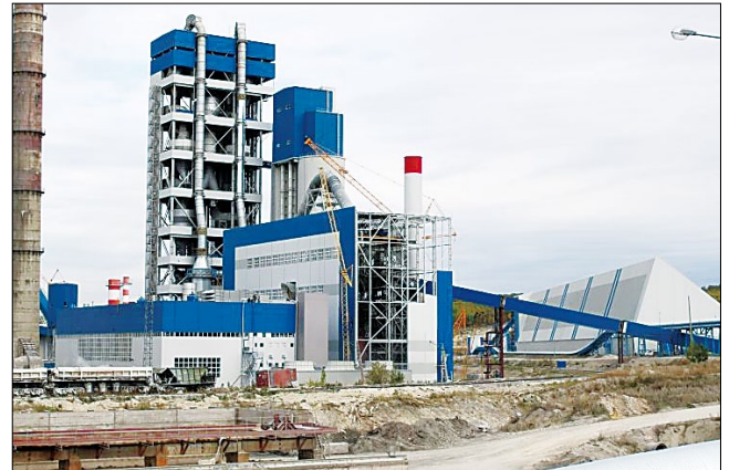
Новая технологическая линия сухого способа производства на «Мордовцементе»
