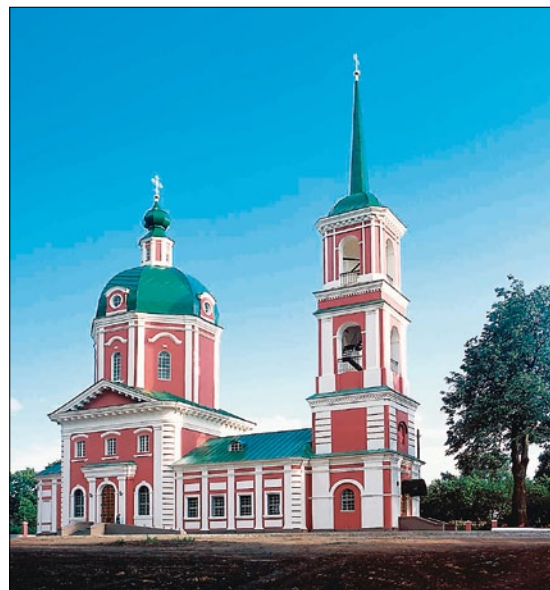
Усадебная церковь Успения Пресвятой Богородицы была построена в 1778 г. и прослужила четырем поколениям семьи Тютчевых. После смерти Ф.И.Тютчева усадьба стала приходить в упадок. Весной 1930 г. церковь была закрыта и пустовала, а во время Великой Отечественной войны взорвана. К 200-летию Ф.И. Тютчева по проекту института «Спецпроектреставрация» (архитекторы О.В. Клемапова, М.Г. Болот-никова, О.А. Грозева) церковь Успения Пресвятой Богородицы была заново построена на новом месте. Финансирование постройки взяла на себя группа «Кнауф»
