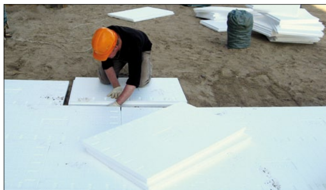
Применение пенополистирола (EPS) для теплоизоляции подземной части здания
