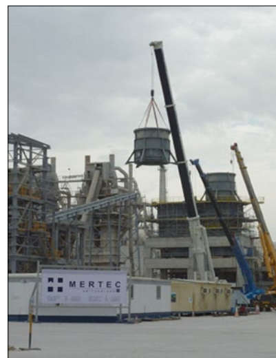
Рис. 3. Монтаж обечаек корпуса новой двухшахтной печи
