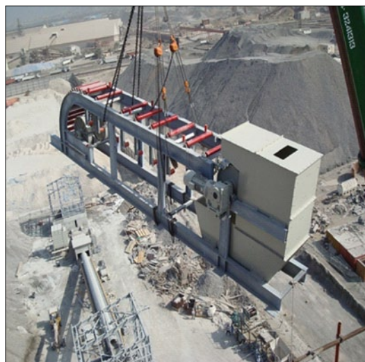
Рис. 2. Монтаж блока вертикального конвейера, предварительно собранного на заводе Мертек
