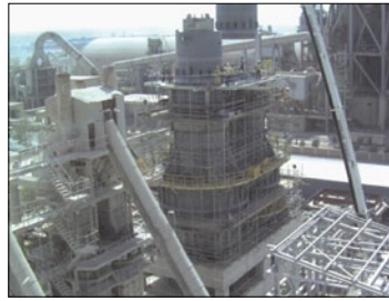
Рис. 5. Завершение работ по монтажу печи
