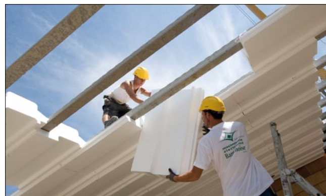
Укладка объемных кровельных элементов сложной формы
