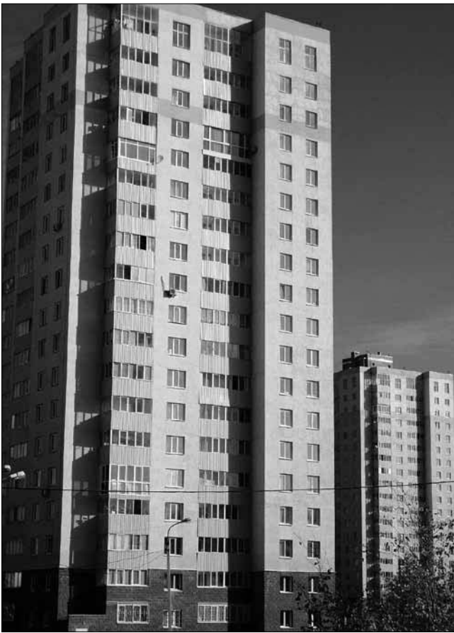
Многоэтажные жилые дома в районе Сипайлово г. Уфы с наружными стенами из автоклавных газобетонных блоков и фасадной отделкой в виде декоративно-защитного покрытия на основе материалов системы «Баумит»
