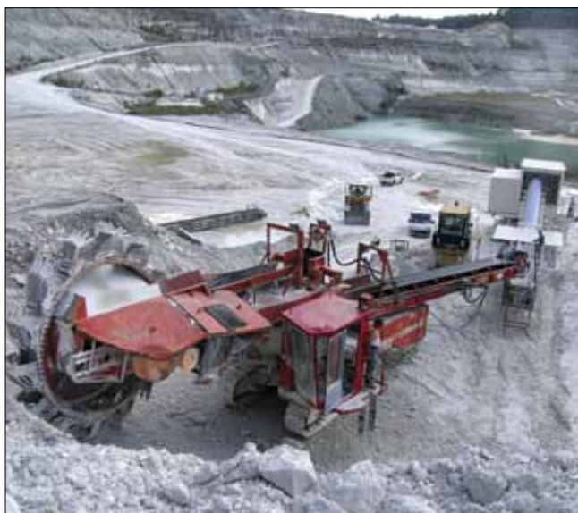
Рис. 10. Роторный экскаватор, мобильный шламоприготовитель
