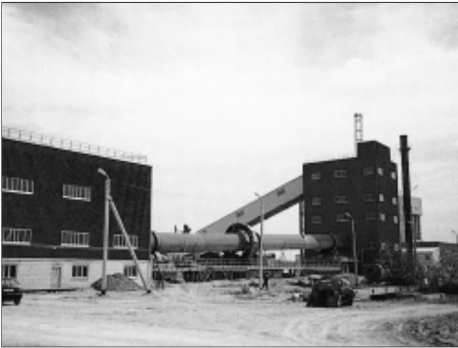
Рис. 7. Общий вид вращающейся печи \varnothing 2,5 \times 75 м АО «ЗККСМ»
