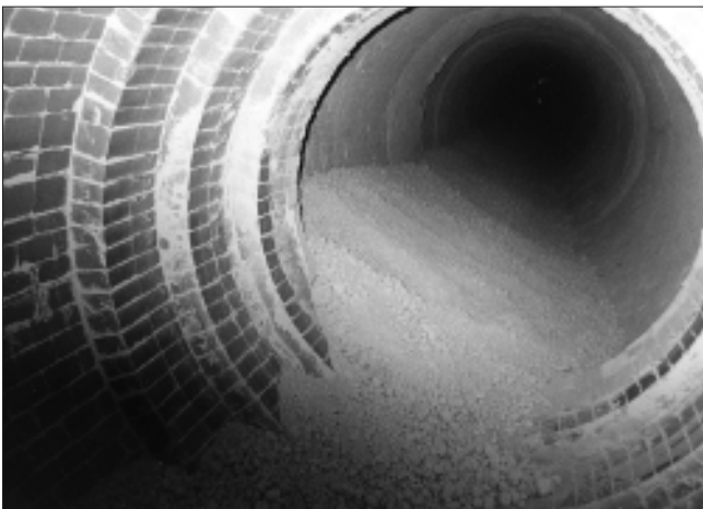
Рис. 9. Порог из огнеупорного кирпича печи \varnothing 2,5 \times 75 м АО «ЗККСМ»
