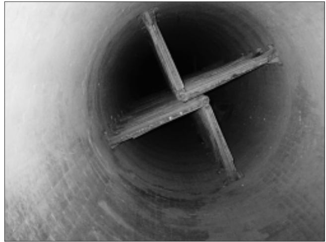
Рис. 8. Ячейковый теплообменник печи \varnothing 2,5 \times 75 м АО «ЗККСМ»
