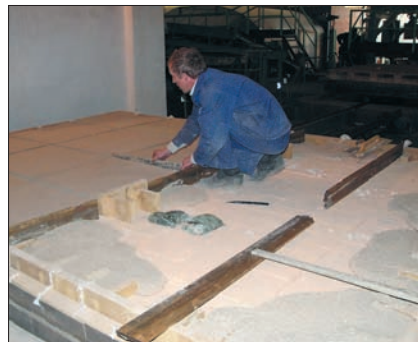
Ремонт футеровки печной вагонетки
