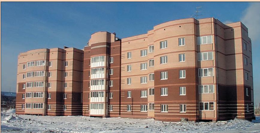
При строительстве дома для работников завода использовали кирпич объемного окрашивания
