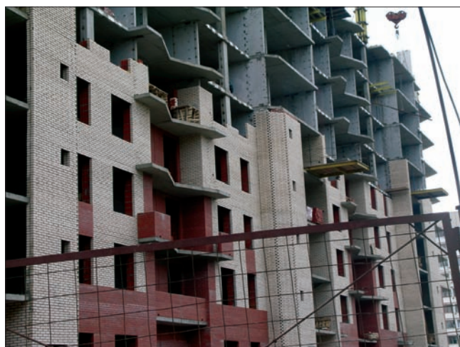
Возведение многоэтажного жилого дома с применением керамического сверхпоризованного камня 10,8 НФ производства ОАО «Победа ЛСР»
