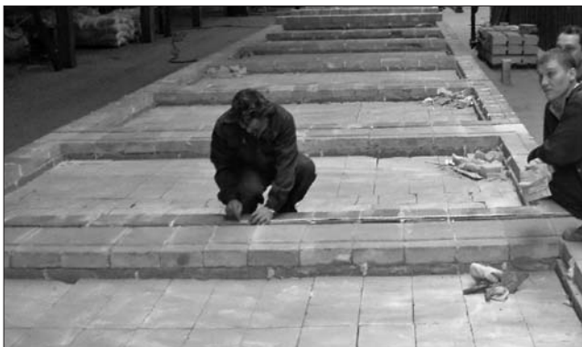
Рис. 2. Рабочий процесс монтажа элементов футеровки
