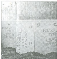
Рис. 1. Гидроизоляция оснований и стен ламелями VOLCLAY
