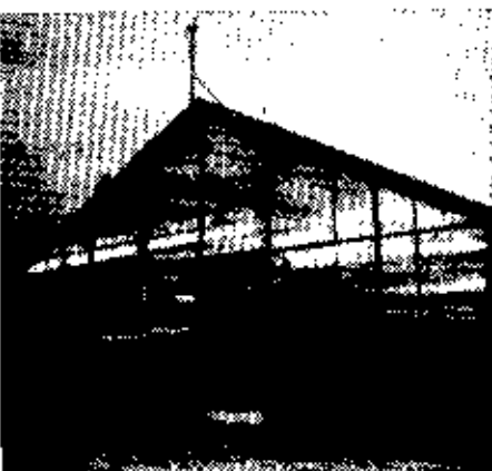
Рис. 5. Теплица, остекленная двойными панелями с перегородками из макролона в г. Мурманске
