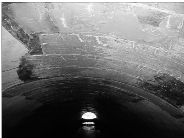
Рис. 5. Усиление арочных пролетных строений автодорожного моста для пропуска повышенной нормативной нагрузки углеродным волокном фирмы SIKА®
