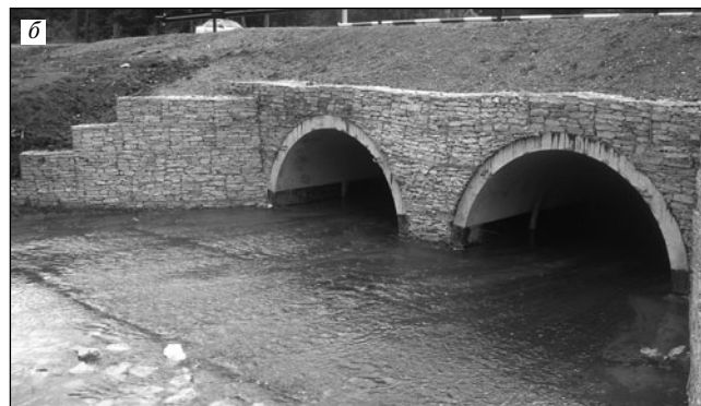
Рис. 1. Возведенные малопролетные засыпные мосты в Республике Башкортостан: а – трехшарнирный арочный мост пролетом 6 м (г. Янаул, лето 2007 г.); б – двухпролетный арочный мост пролетом 2×4 м (г. Бирск, лето 2007 г.)
