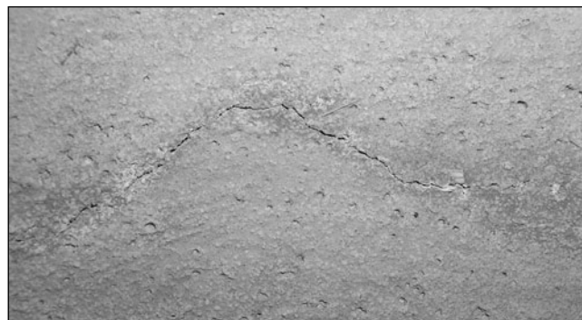
Рис. 3. Характер трещинообразования на внутренней поверхности конструкции засыпного арочного моста пролетом 4 м, преимущественно в коньковой части
