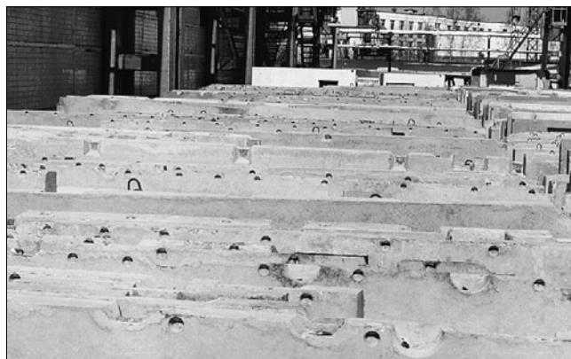
Рис. 1. Плиты перекрытий дома ГМС-1 на складе ОАО «Кунцевский комбинат ЖБИ-9»
