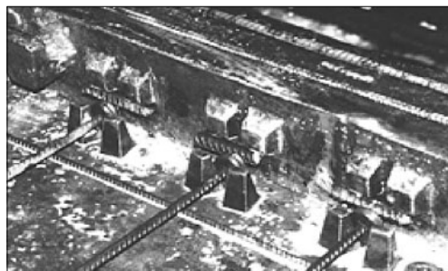
Рис. 5. Напрягаемые стержни с внутренними анкерами в упорах формы плиты перекрытия дома ПД-4
