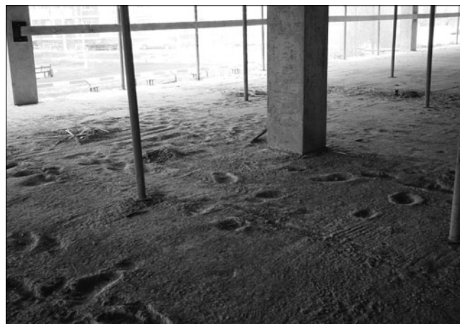
Рис. 2. Фрагмент монолитной железобетонной плиты зимнего бетонирования
