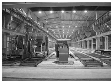
Рис. 1. Общий вид пролета цеха Новочебоксарского ДСК с длинными ( l = 104 м) стендами безопалубочного формирования предварительно напряженных плит пустотного настила из керамзитобетона класса по прочности В30, марки по плотности D1800
