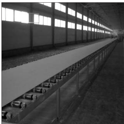
Конвейер нового цеха по производству ГКЛ на ООО «Арачинский гипс» (Казань)
