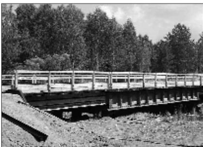
Рис. 1. Общий вид моста с пролетными строениями из дощато-гвоздевых коробчатых блоков через р. Ик
