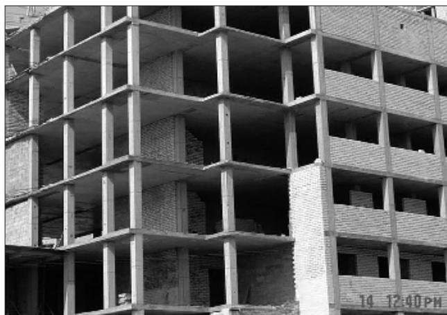
**Рис. 3.** Возведение монолитного несущего каркаса из легких бетонов на пористом шлаковом гравии Новолипецкого металлургического комбината и наружных стен с монолитной теплоизоляцией из полистиролбетона (облицовка кирпичом) при строительстве жилого здания в г. Воронеже
