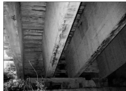
Рис. 3. Фрагмент моста с пролетными строениями из клееных балок длиной 18 м на деревянных свайных опорах
