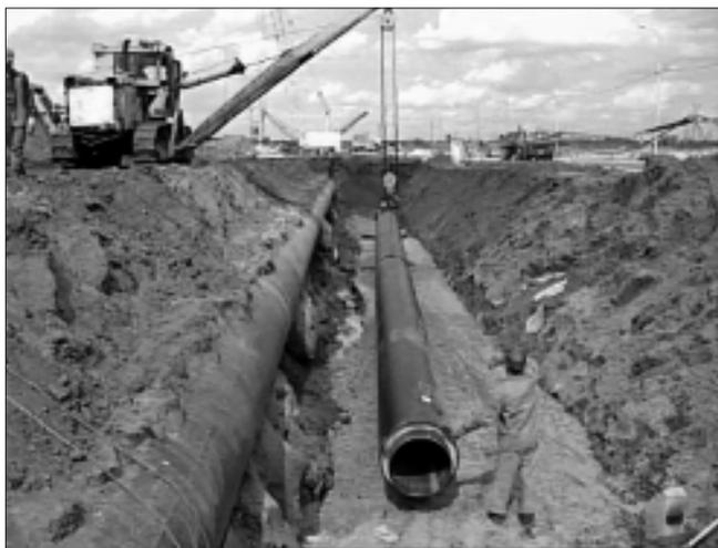
**Рис. 1.** Бесканальная прокладка стальных теплопроводов с пенополиуретановой изоляцией
