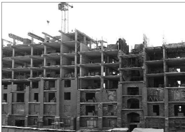
Рис. 1. Строительство жилого здания в Иркутске с трехслойными кирпичными стенами при среднем слое из монолитного полистиролбетона марки по плотности D200–D250
