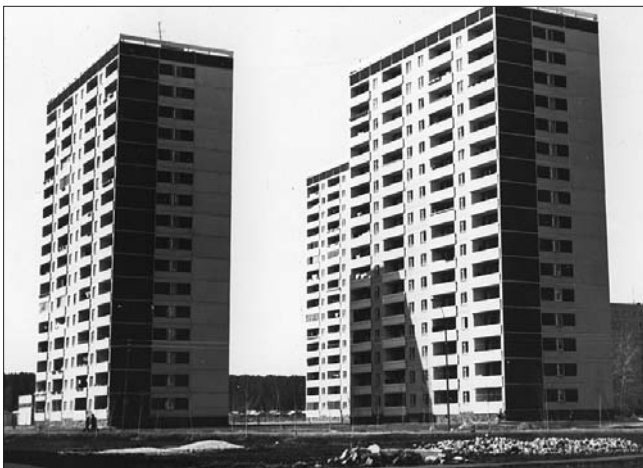
Рис. 3. Крупнопанельные здания высотой 9–16 этажей с использованием двухмодульных газозобетонных панелей в Екатеринбурге
