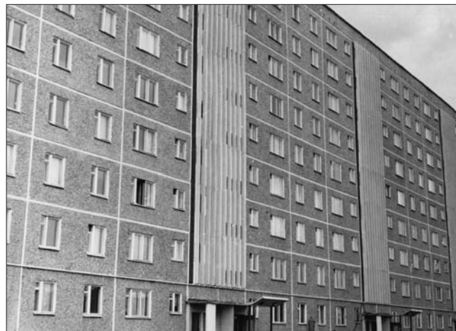
Рис. 3. Крупнопанельные здания высотой 9–16 этажей с использованием двухмодульных газозобетонных панелей в Екатеринбурге
