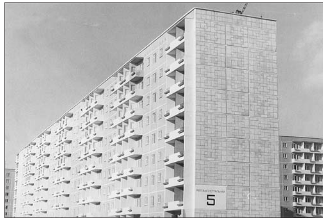
Рис. 2. Отделка панелей цементно-песчаными плитами
