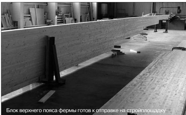
Блок верхнего пояса фермы готов к отправке на стройплощадку
