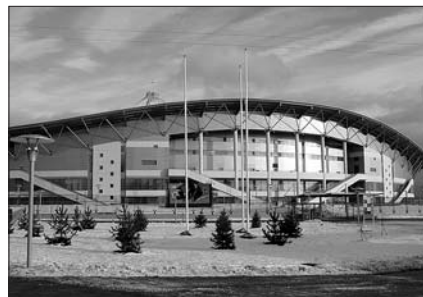
Крытый конькобежный центр в Крылатском
