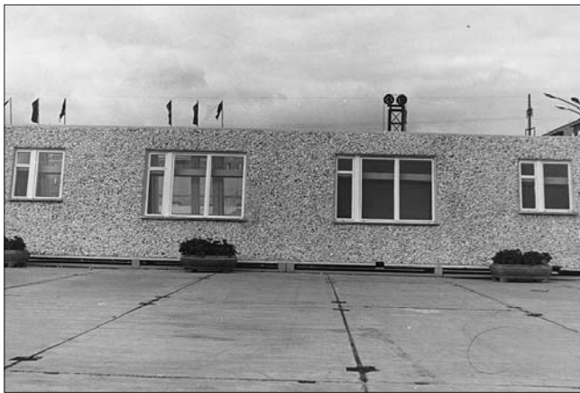
Рис. 4. Предварительно напряженная газозолобетонная панель длиной 12 м
