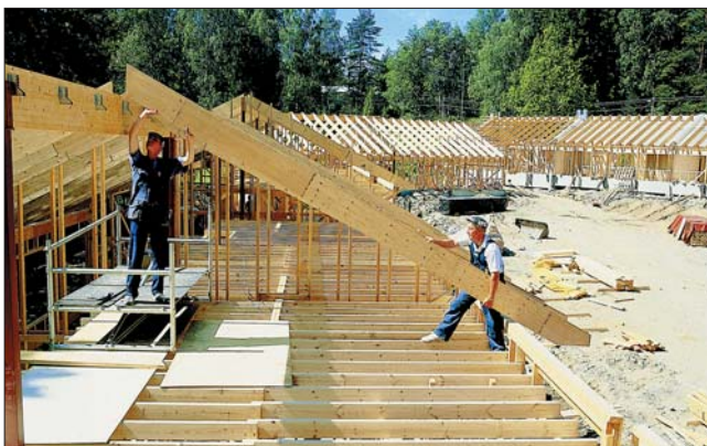
LVL-материалы имеют небольшую массу. Пригодны для возведения несущего каркаса и стропил
